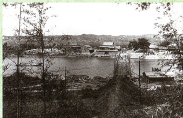
昭和9年架設の初代沖ノ旦橋(工事中)
